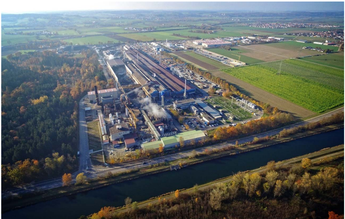
Abbildung 3: Standort Herbertshofen zum Zeitpunkt 2018 (Quelle: Max Aicher GmbH & Co. KG/Lech-Stahlwerke)
