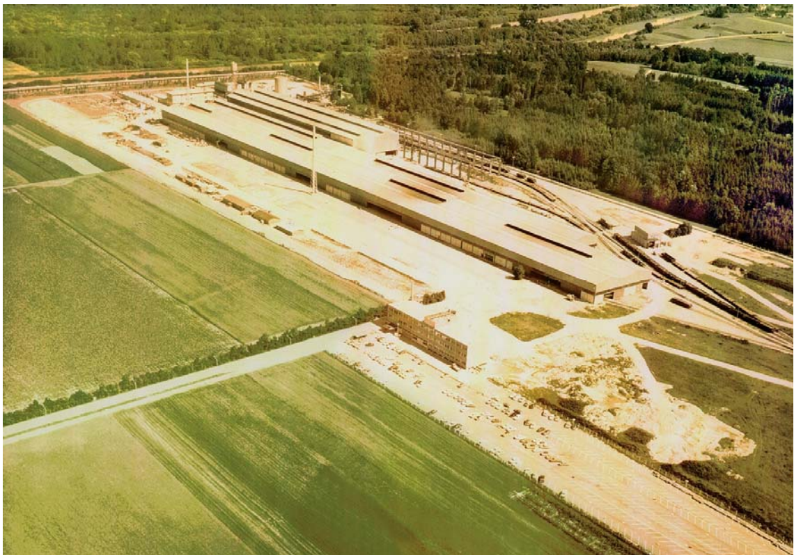
Abbildung 1: Standort Herbertshofen zum Zeitpunkt 1975 (Quelle: Max Aicher GmbH & Co. KG/Lech-Stahlwerke)
