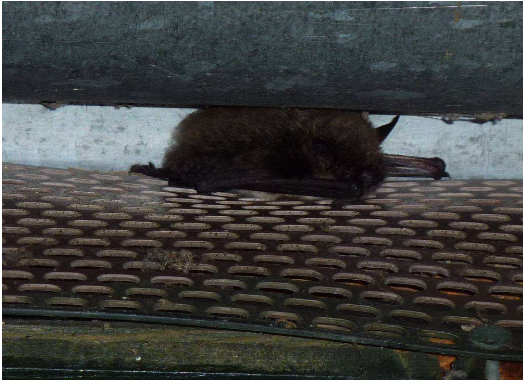
Abb. 3 : Bart- oder Brandtfledermaus unter der Dachrinne eines der beiden Verwaltungsgebäude östlich des engeren Eingriffsbereiches.
